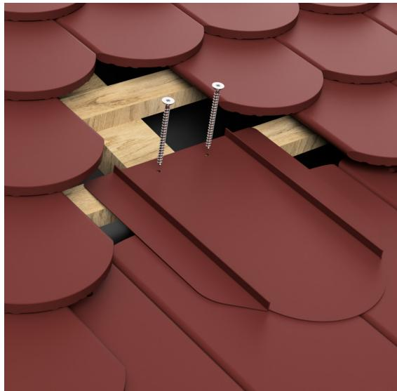
Fixieren Sie die Ersatzplatte mit nichtrostenden Holzbauschrauben – empfohlen 4x20 mm.
